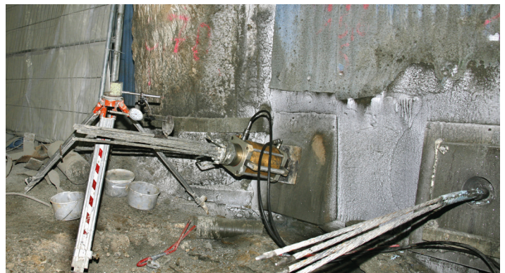
Spannen von Litzenanker mit Ankerzement® hergestelltem Verpresskörper
