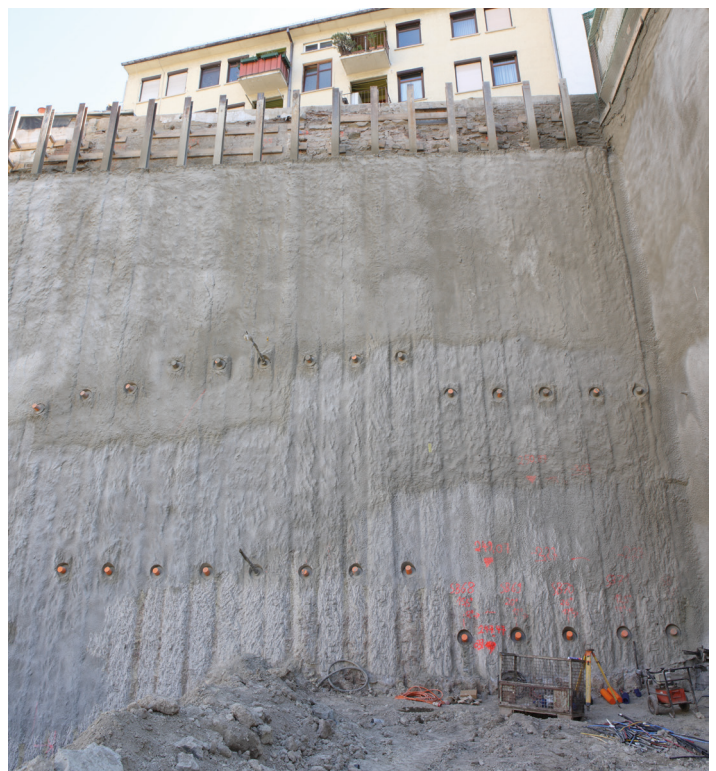
Mit Ankerzement® rückverankerte Bohrpfehlwand
