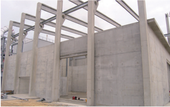
Industriehalle, betoniert mit CEM II/A-M (V-LL) 42,5 N
