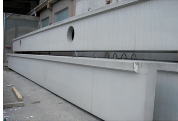
Fertigteile, betoniert mit Fastcrete® plus
