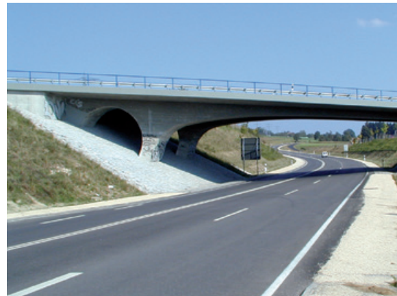
Brücke, hergestellt mit Portlandkalksteinzement CEM II/A-LL 32,5 R
