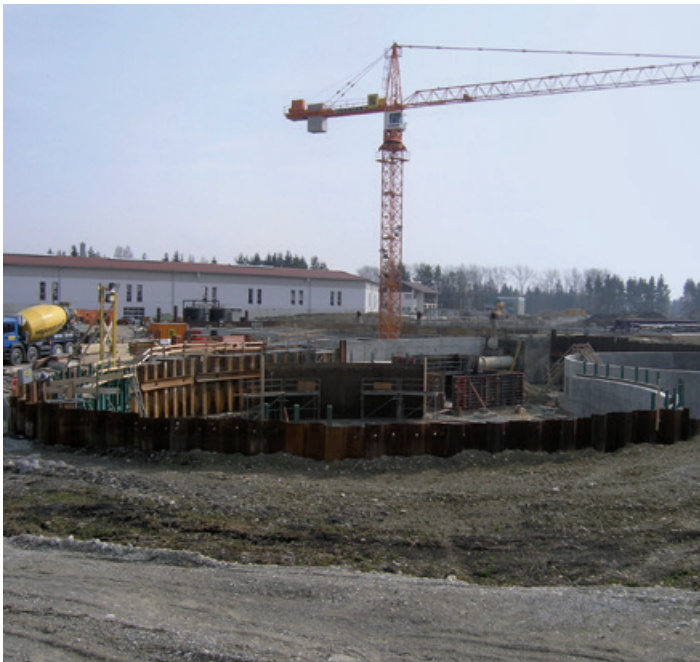
Aufbereitungsbecken einer Kläranlage, hergestellt mit CEM I 32,5 N-SR 3
