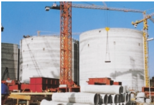
Kohlesilos: Fundamente, Sohlen, Kegelspitze für Ausläufe, Stützen, Decken und Balkenroste mit CEM III/B 32,5 N-NW/HS betoniert.
