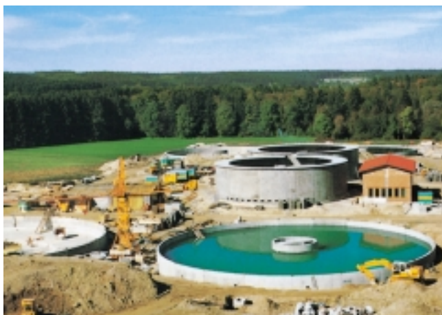
Bau eines Klärbeckens.
